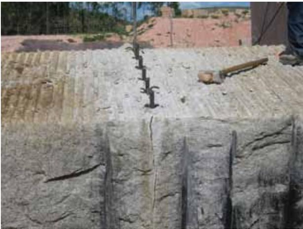
**Foto 6.11** – Finalização do corte de um bloco através de cunhas mecânicas. Notar irregularidade do talho vertical, município de Ecoporanga.
