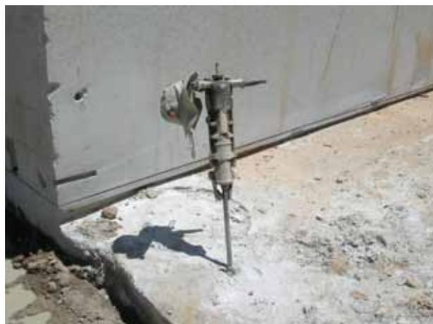
**Foto 6.9** – Detalhe da regularidade da linha de corte do plano horizontal (plano do levante) com fio diamantado. Em primeiro plano, martelete pneumático manual utilizado nas perfurações.
