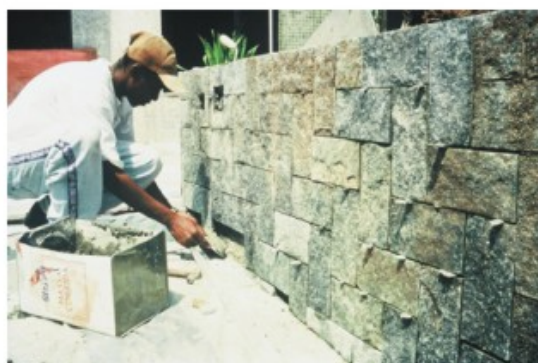
Foto 84 - Aplicação vertical de lajotas de pedra Paduana ou Miracema, com argamassa cimentícia convencional pastosa.
