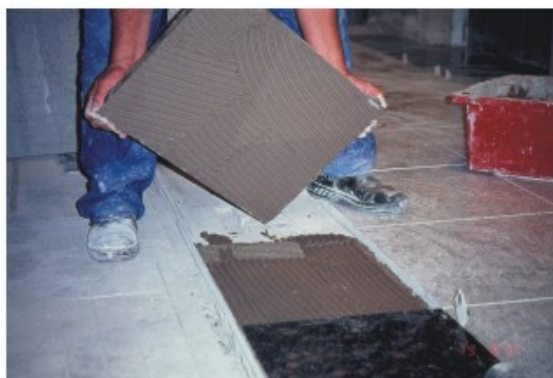
Foto 75 - Aplicação de argamassa colante no tardo da placa de rocha e no contrapiso, processo de dupla camada.
