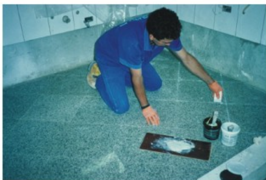
Foto 79 - Aplicação de rejuntamento de base epóxi (bicomponente).
