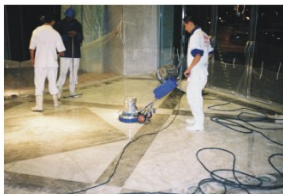
Foto 54 - Trabalho de restauração (repolimento) de piso em mármore e granito.
