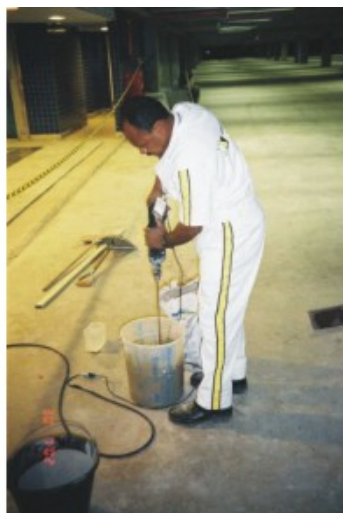
Foto 74 - Misturador elétrico para homogeneização de argamassa colante.
