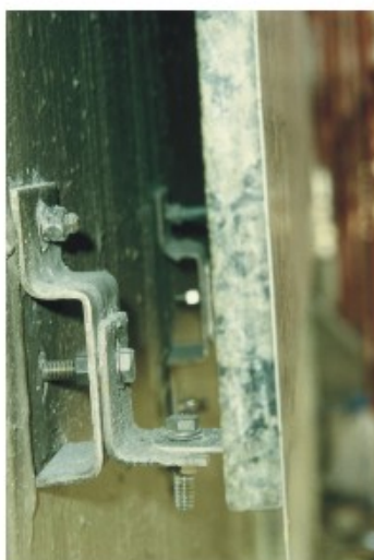
Fotos 90 - Detalhe de fachadas aeradas/ventiladas revestidas em granito.
