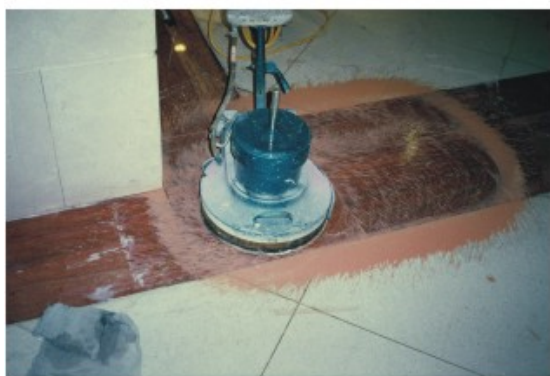
Foto 53 - Equipamento do tipo "enceradeira", utilizado no repolimento de mármore.
