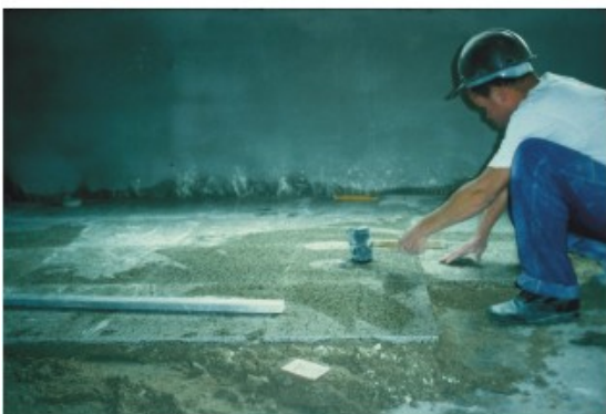
Foto 71 - Assentamento da placa de rocha com auxílio de martelo de borracha.
