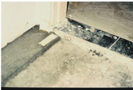
Foto 73 - Detalhe da camada de argamassa niveladora, retratada na foto 75.
