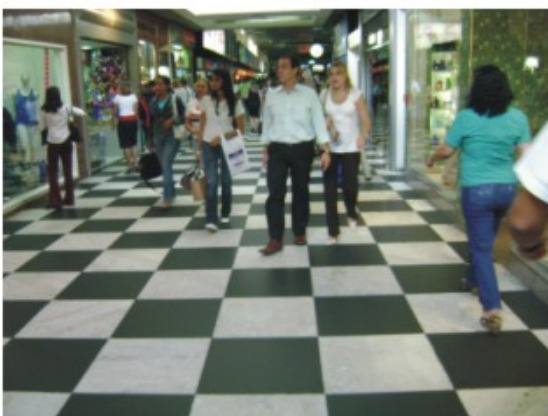
Foto 59 - Piso de granito (preto) e mármore (branco) sujeito a alto tráfego de pedestres (Aeroporto de Congonhas São Paulo).
