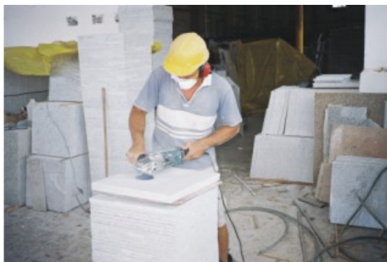
Foto 103 - Eliminação dos resíduos de granalha por meio de lixamento, visando prevenir manchamentos por oxidação.
