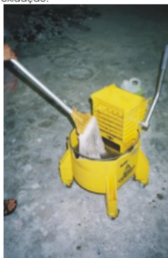
Foto 105 - Limpeza manual em piso de rocha, utilizando-se pano úmido.
