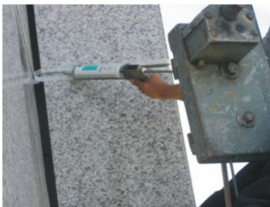
Foto 94 - Detalhe da foto 97, com aplicação de silicone em juntas de fachada.
