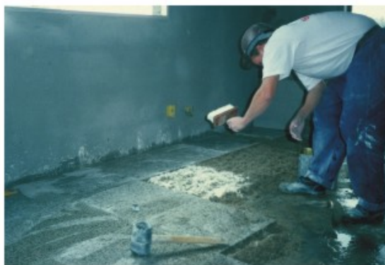
Foto 70 - Aspersão de água sobre o cimento branco polvilhado.
