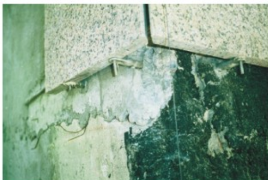
Fotos 91 - Detalhe de fachadas aeradas/ventiladas revestidas em granito.
