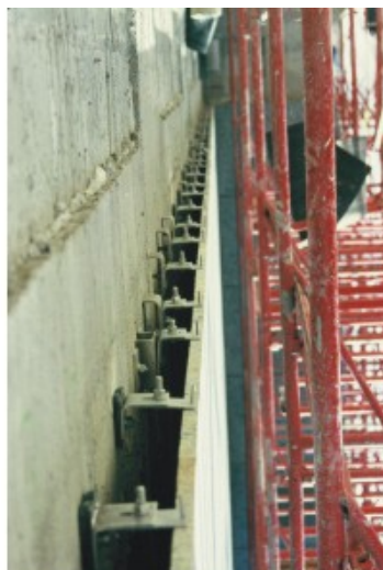
Fotos 92 - Detalhe de fachadas aeradas/ventiladas revestidas em granito.
