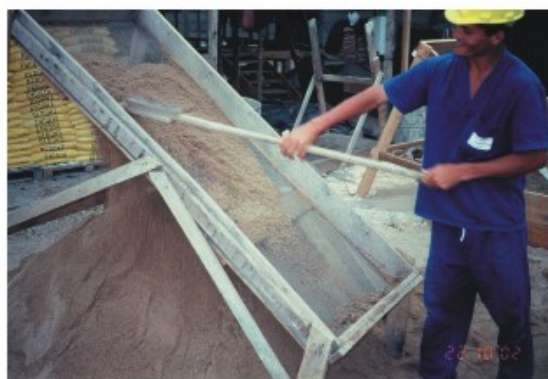
Foto 66 - Peneiramento de areia previamente lavada, para remoção de impurezas (seixos, torrões de argila, fragmentos de madeira, etc.)
