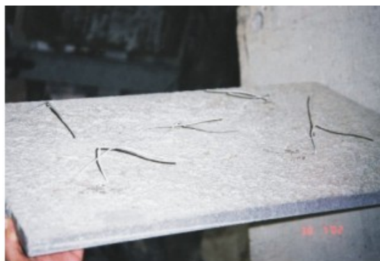
Foto 86 - Utilização de grampos (arame inoxidável), no tardo de placa rochosa, para assentamento em paredes e fachadas.
