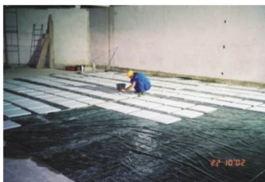
Foto 96 - Utilização de produto impermeabilizante no tardo das placas rochosas, para aplicação de piso em área sujeita à umidade ascendente.
