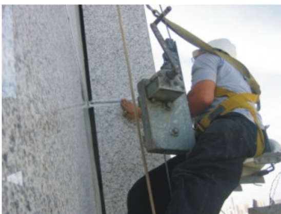
Foto 93 - Aplicação de rejuntamento de silicone em juntas de fachada aerada/ventilada.
