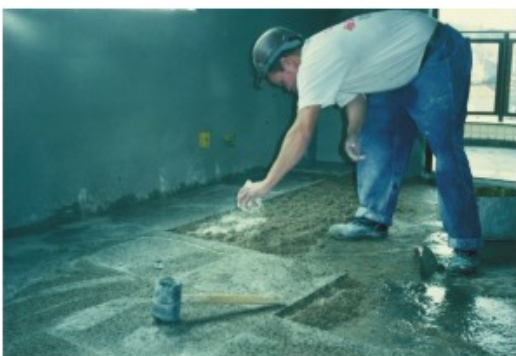
Foto 69 - Polvilhamento de cimento branco sobre argamassa semi-seca (tipo farofa).
