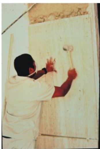
Foto 87 - Aplicação de placas de mármore, utilizando-se argamassa colante.
