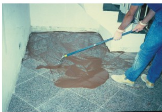
Foto 78- Aplicação de rejuntamento à base de calda de cimento.
