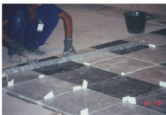
Foto 76 - Utilização de espaçadores plásticos para garantir uniformidade das juntas.
