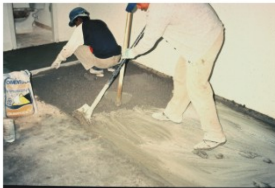
Foto 72 - Aplicação de camada de argamassa niveladora, sobre o contrapiso, possibilitando o assentamento com argamassa colante.
