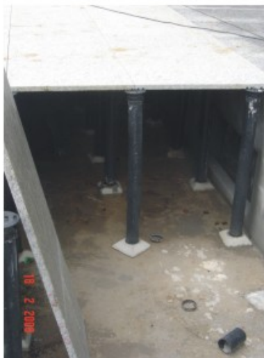
Foto 88 - Detalhe de piso elevado, utilizando-se placas de granito.
